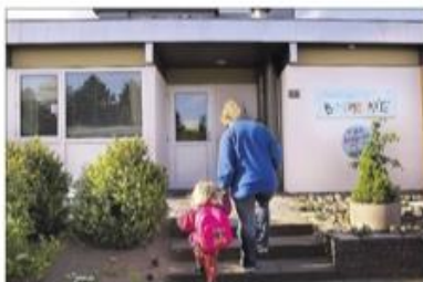
Den gamle børnehaven på Vinkelvej skal jævnes med jorden, så der kan opføres nye rækkehuse. Arkivfoto
