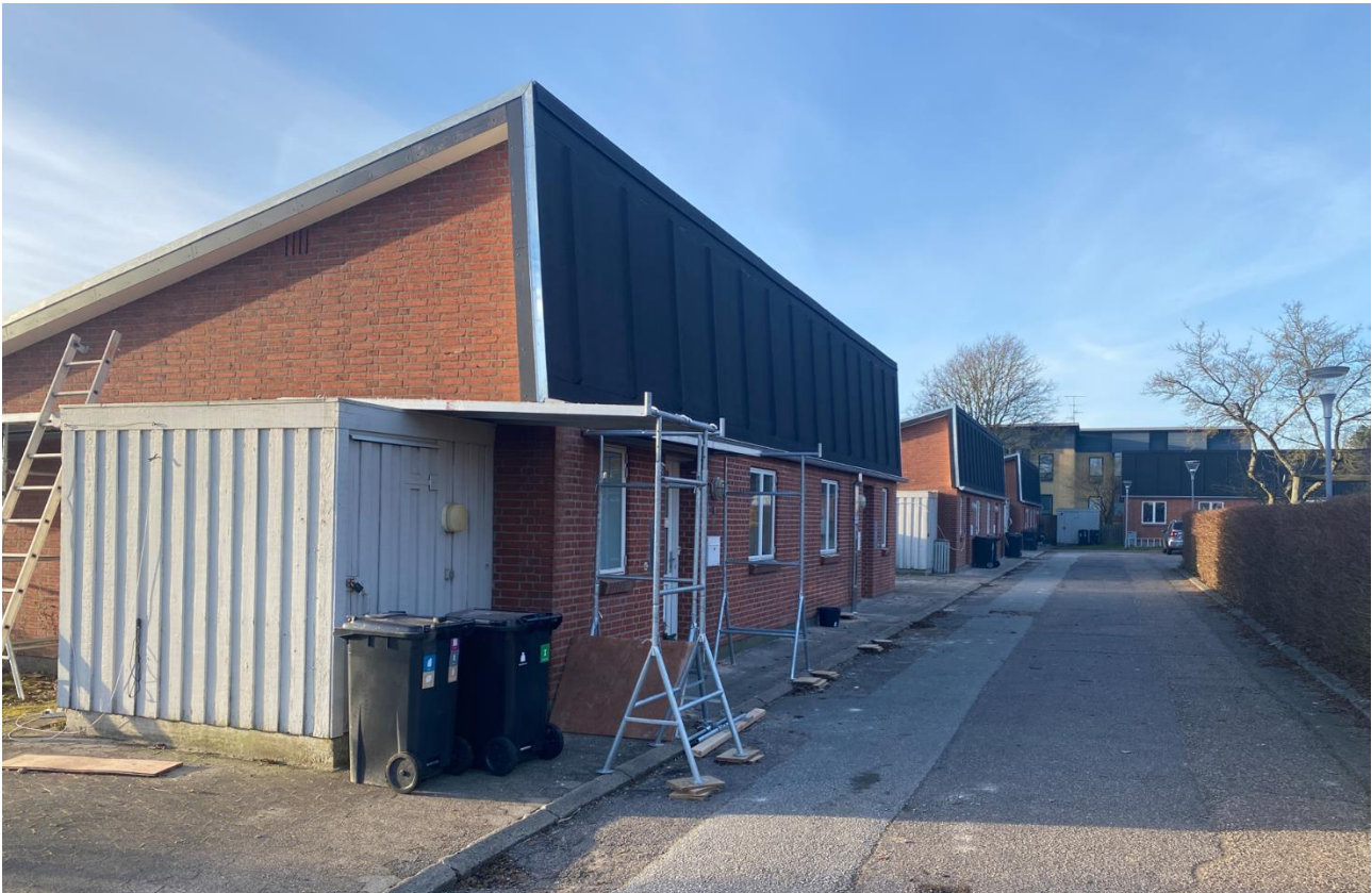
Tagrenovering - Arden og omegn, den 20. december 2024
