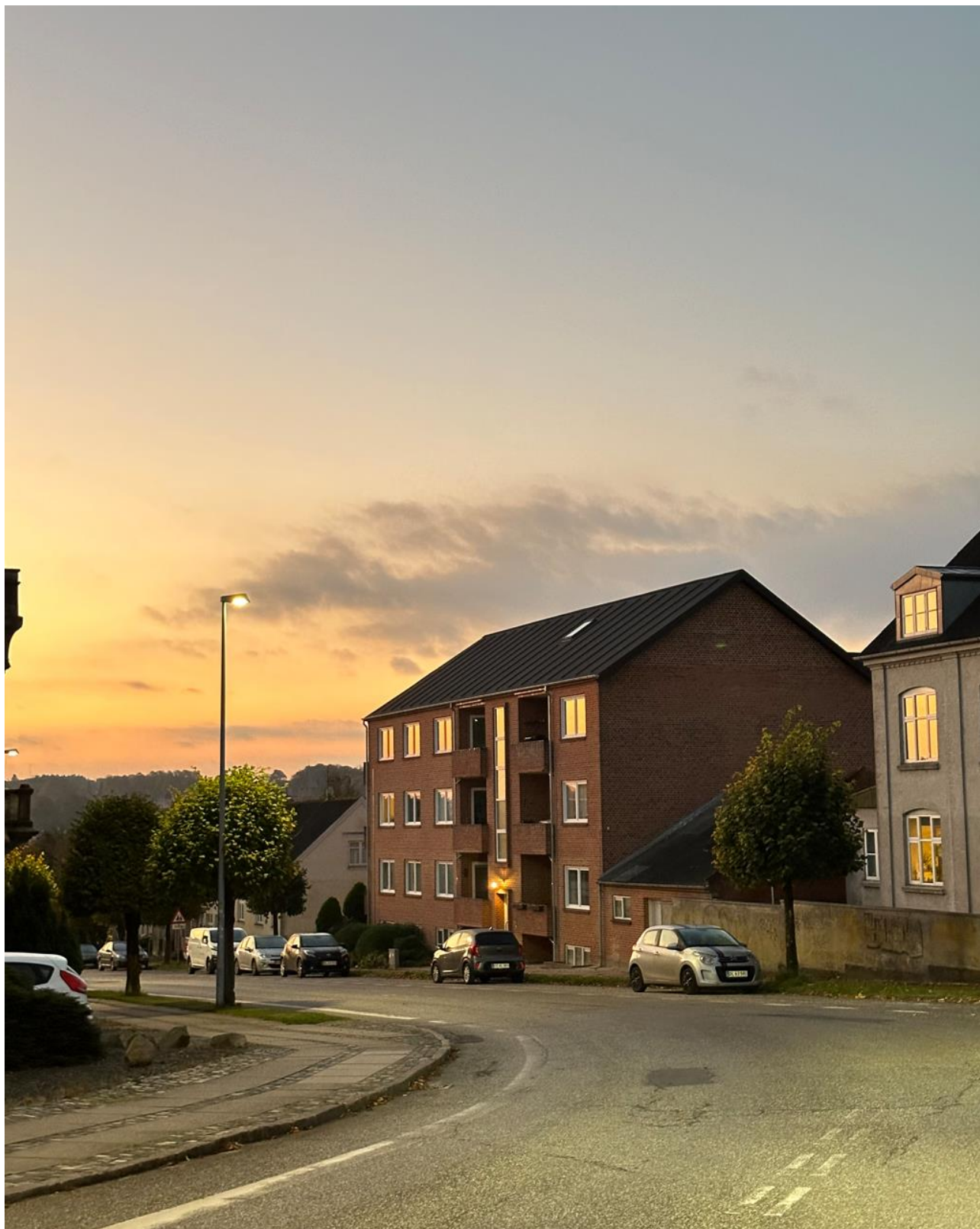
Tagrenovering - Solgården afd. 2, den 17. oktober 2024
