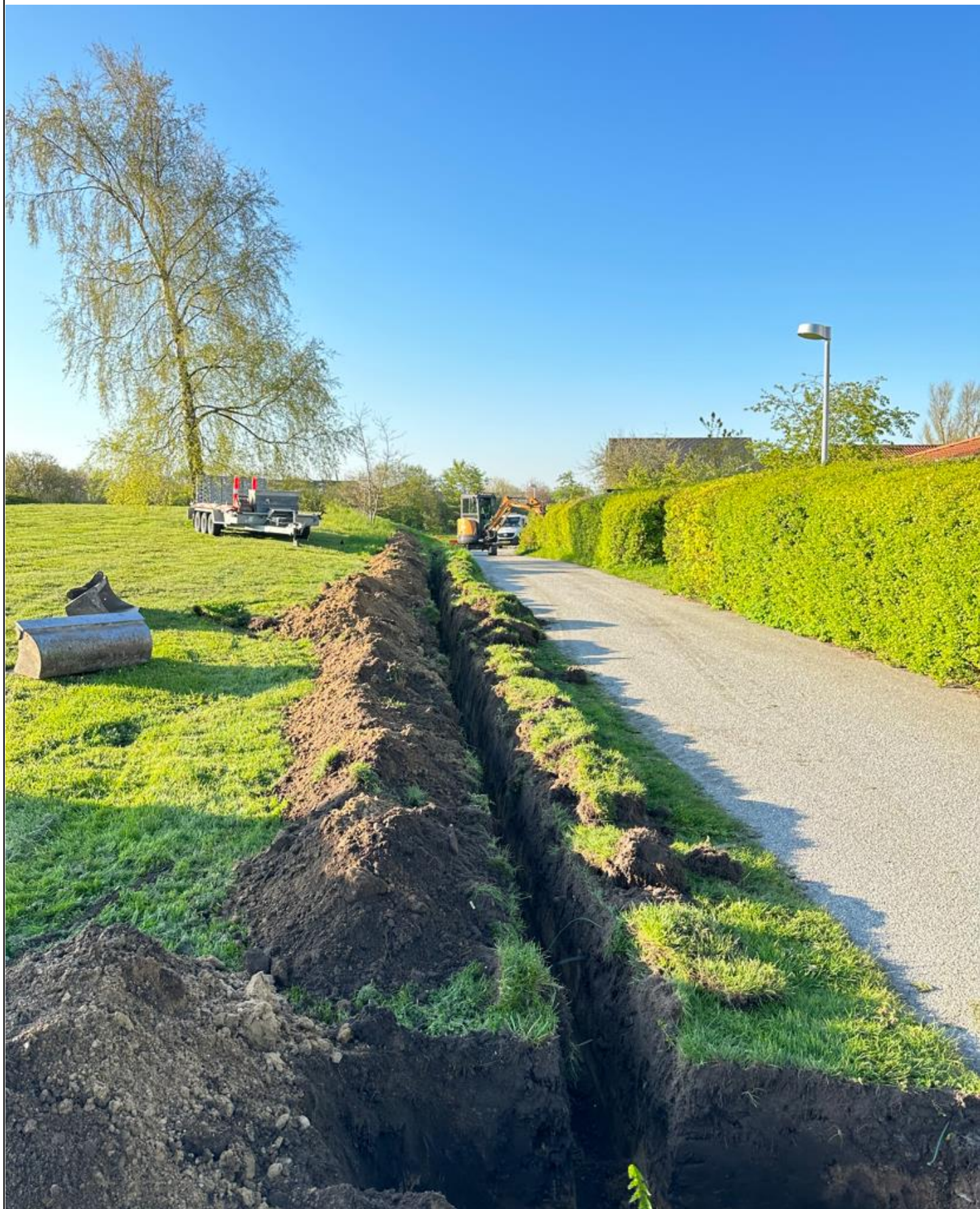
Installation af fibernetværk i Hohøje
